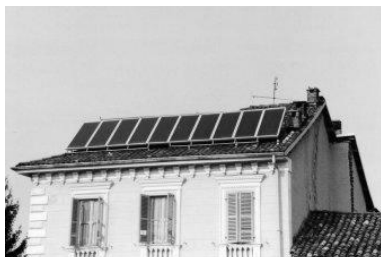
Foto 1 posizionamento sopraelevato non consentito dal presente allegato
