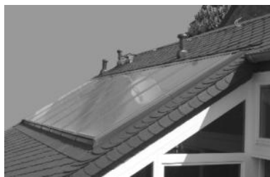
Foto 3 posizionamento secondo la pendenza della copertura: dettaglio
