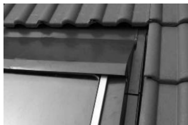
Foto 4 posizionamento secondo la pendenza della copertura: dettaglio
